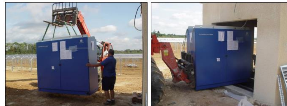
Figure 39- Installation d'un onduleur – Source : Valeco
