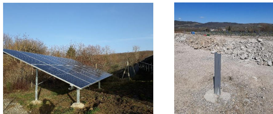
Figure 33- Exemple de pieux forés bétonnés – Source : Valeco
