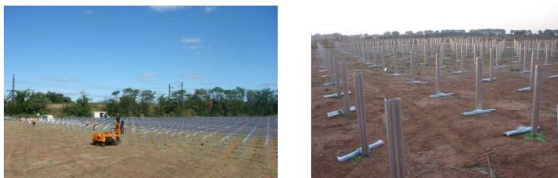
Battage des pieux
