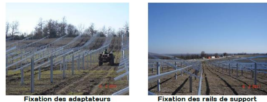
Figure 35 : Montage des structures porteuses – Source : Valeco
