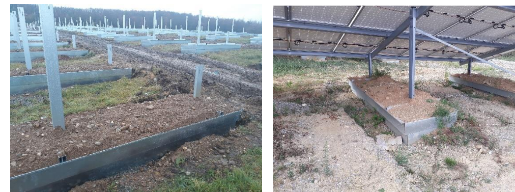
Figure 34- Fondation externe Longrine, centrale Saint Quentin la Tour (09) – Source : Valeco
