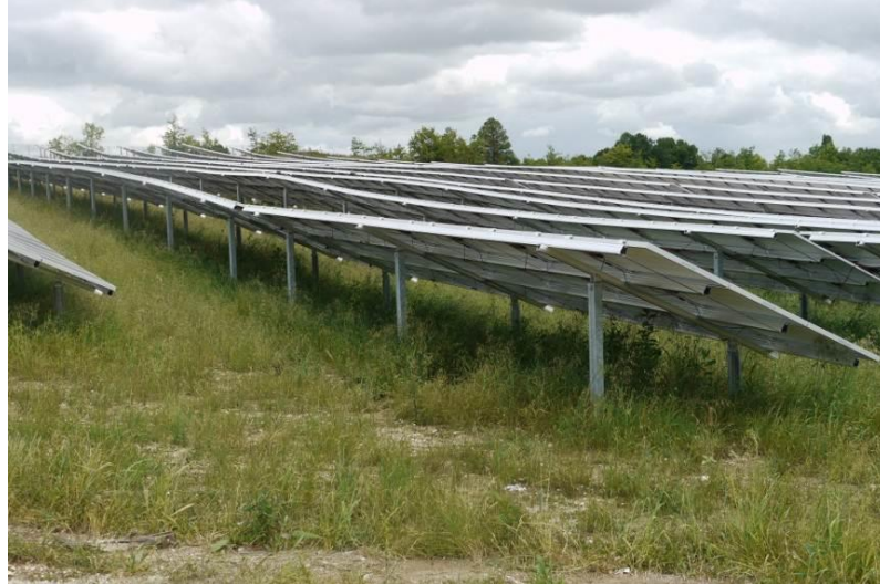
Figure 40- Exemple de revégétalisation un mois après les travaux (centrale du Sycala) – Source : Valeco
