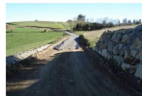
Mise en place du gravier
