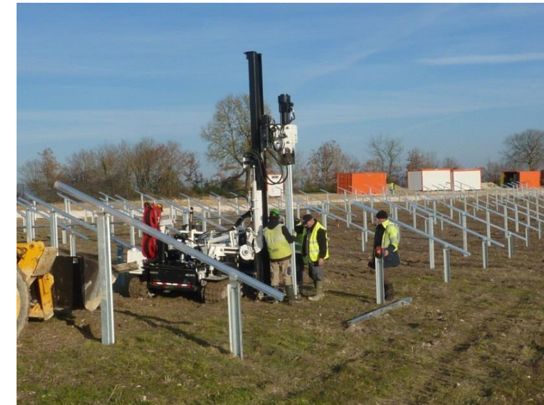
Figure 20- Mise en place de supports de panneaux – Source : Valeco
