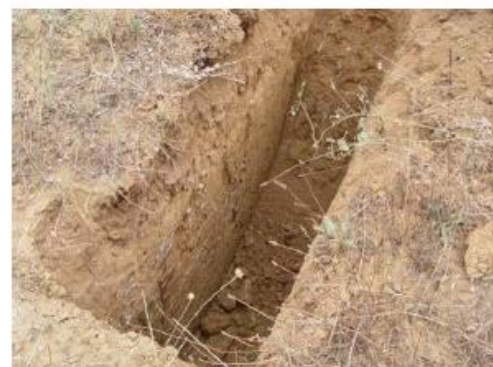
Fouille de sondage
