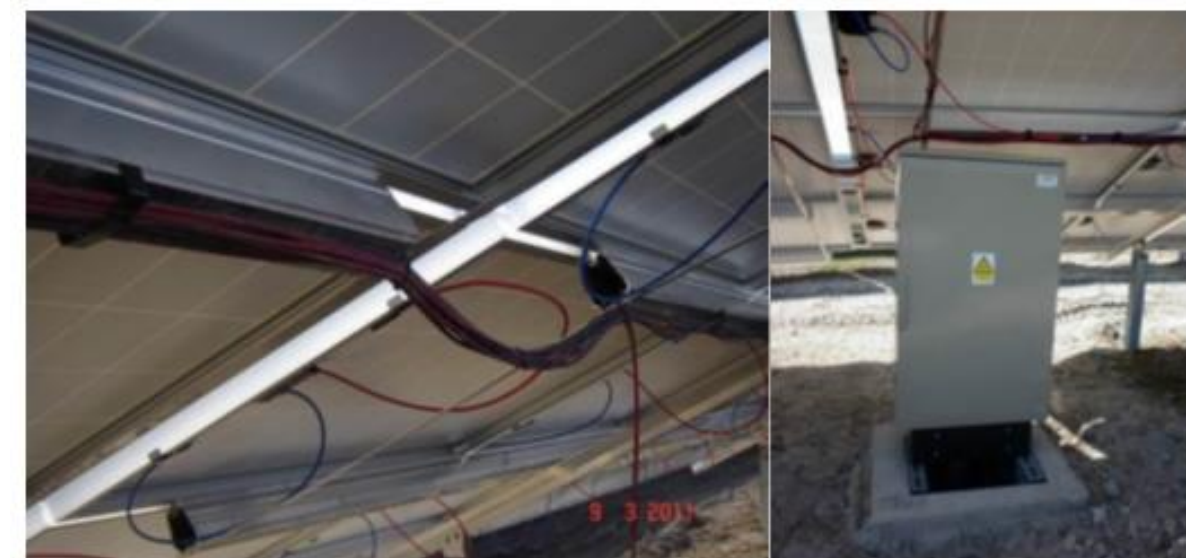
Figure 21- Illustration du raccordement et d'une boîte de jonction – Source : Valeco
