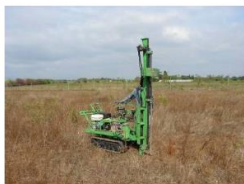
Sondage au pénétromètre
