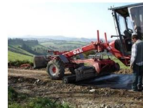
Pose du géotextile
